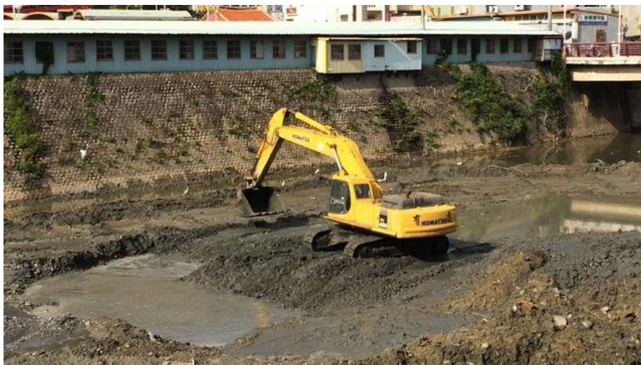
圖 9.5：除非絕對必要，否則避免在河道中使用重型設備。
